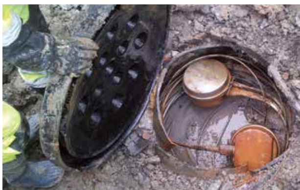
Översvämmad kabelbrunn – inuti T240 är det torrt.
