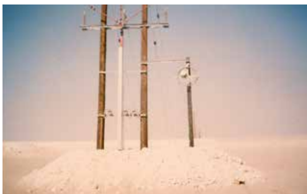
Ingen påverkan från UV-strålning på den rostfria T240 boxen.
