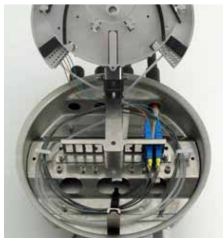
Terminering och skarvning för vindkraftverk.
