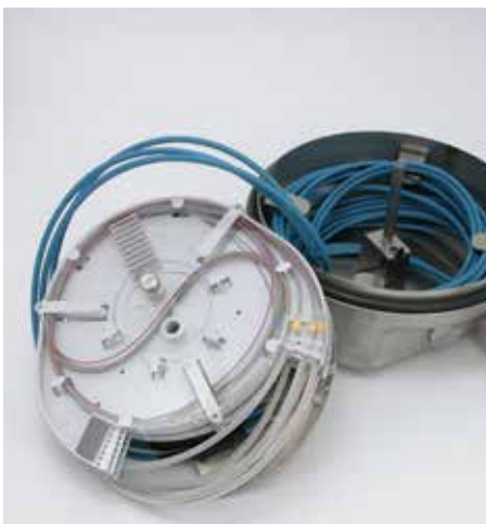
Känslig mikrokabel installation med skyddad förvaring av överskott.
