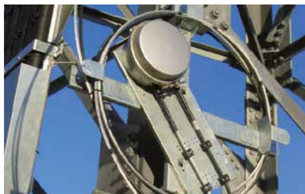
Exempel på installation med OPGW.
