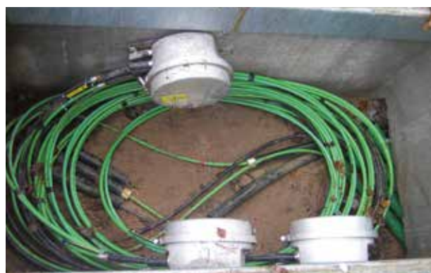
Kabelbrunn med T240.
